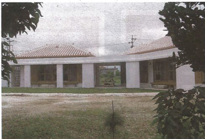
2010年に完成した宮古島市のエコハウス郊外型。母屋と離れのためのテラスは風通しが良く、台所につながっているため食事、団らん、接客の場になっている
